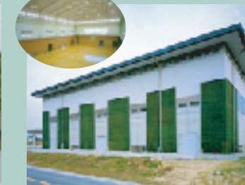
ひょうのうけ 上納池スポーツ公園(愛知県日進市) 面積約3.2haの地区公園。地域の防災拠点としての機能を併せ持つ体育館、グラウンド、テニスコートなどを整備。体育館は道路側の壁面を緑化。
