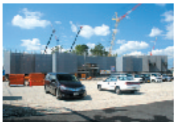
団地は建替工事が進捗中
