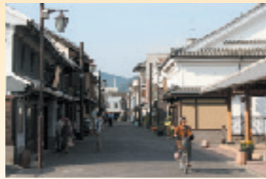
アーケードを撤去 甍った町並み 八町大路 (上写真と同地点)
