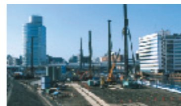
地盤改良工事の様子
