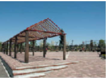
大洲防災公園 (千葉県 市川市) 市街地と一体的に整備
