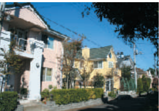
まちなみ環境に配慮した高質の住宅群
