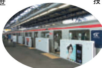
ホームに設けられた安全柵
