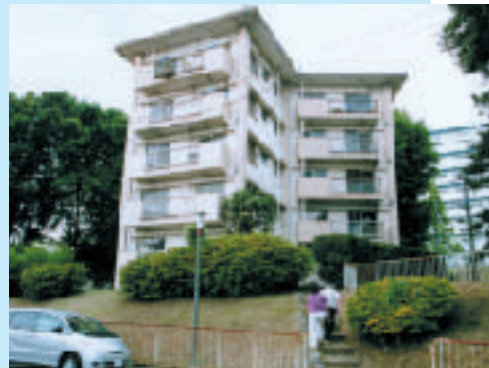
当時は先端的だった星型住宅(スターハウス)
