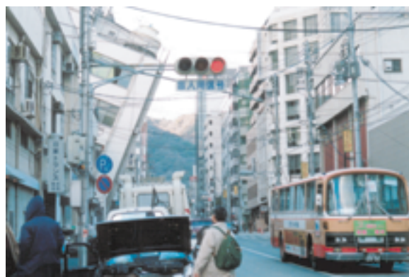
ビルが傾いた 神戸市内三宮地区
