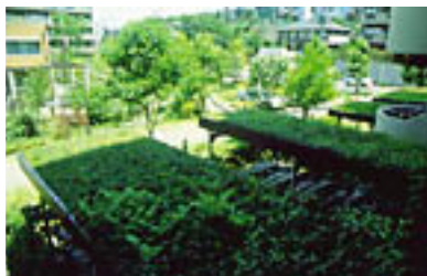
駐輪場などの屋根の緑化
