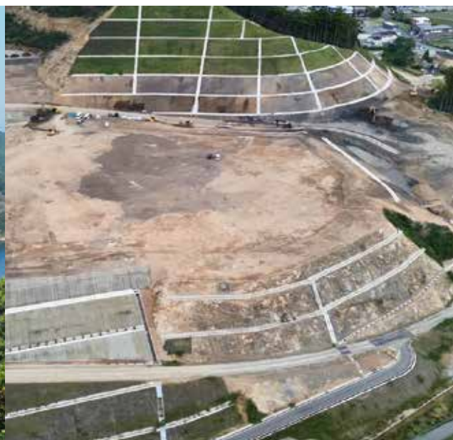
高台造成地(整備中)
