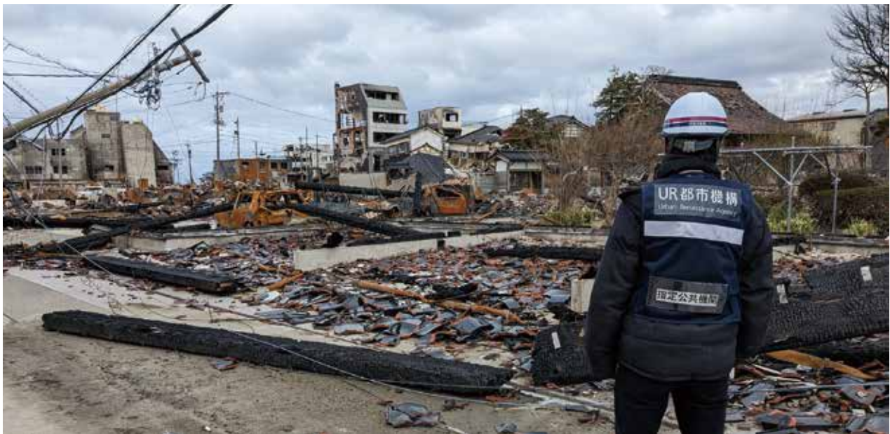
現地の被害状況を確認する職員
