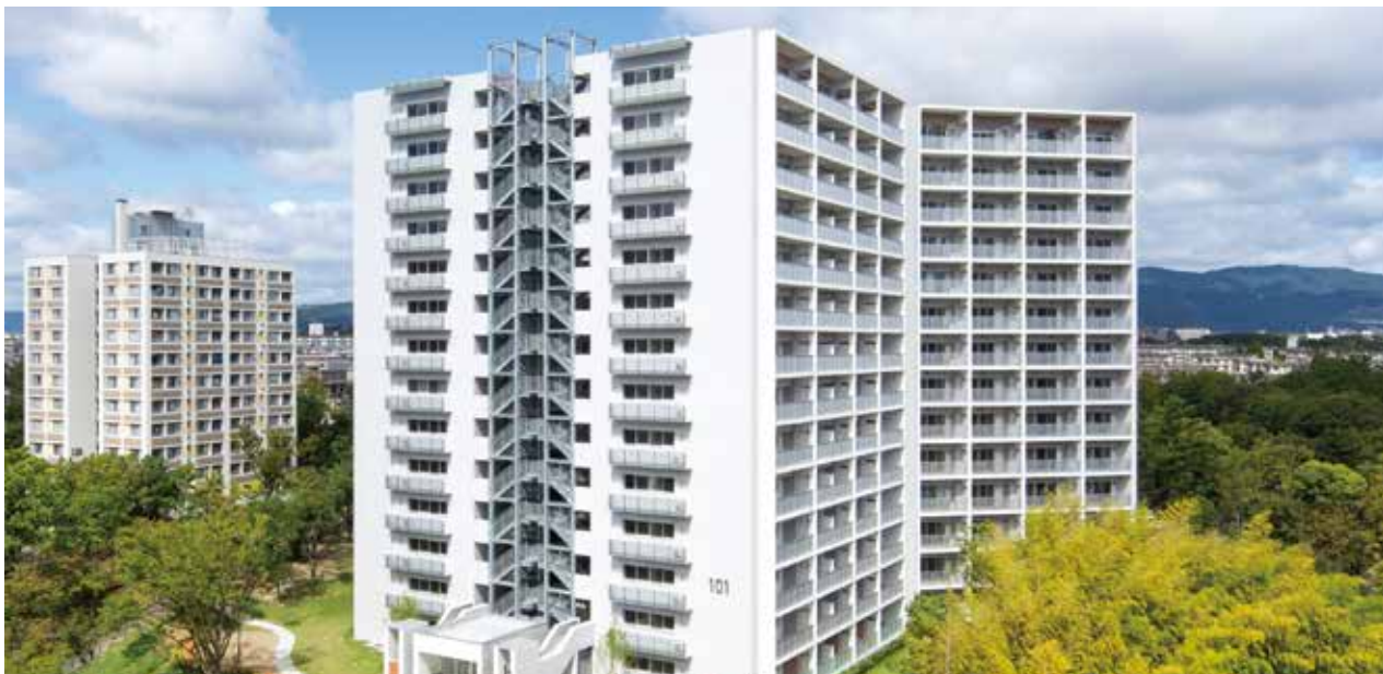
千里グリーンヒルズ竹見台101号棟
