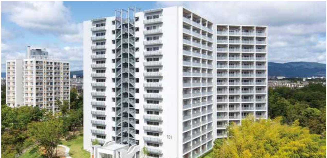
千里グリーンヒルズ竹見台101号棟
