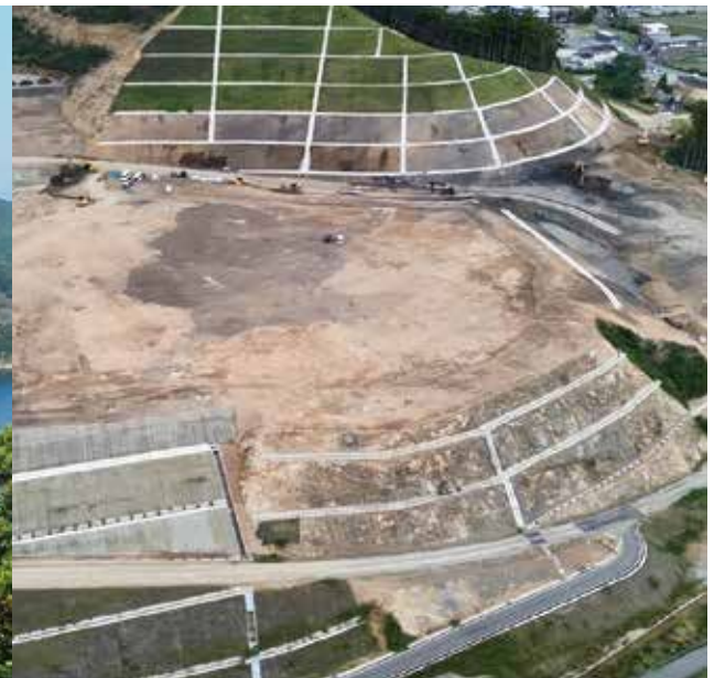
高台造成地（整備中）
