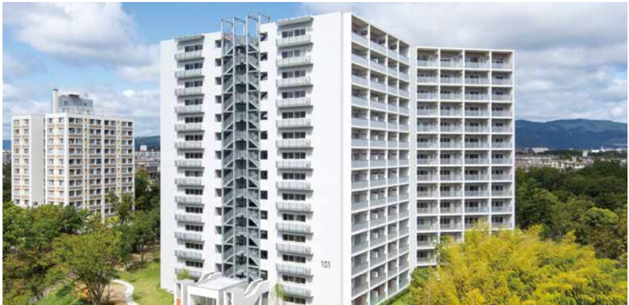
千里グリーンヒルズ竹見台101号棟
