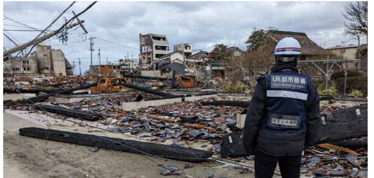
現地の被害状況を確認する職員
