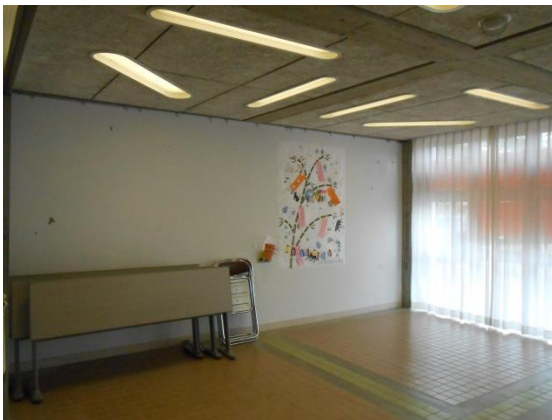
<改修前多目的室>
