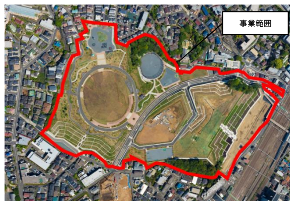
＜工事完成時の航空写真（令和5年4月撮影）＞
