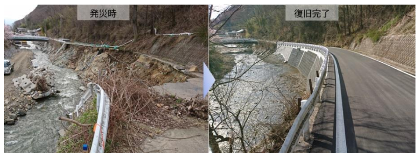
<災害復旧工事マネジメントを活用した工事の復旧状況>
