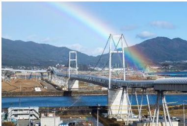
ベルトコンベアの活用による 工期短縮(岩手県陸前高田市)
