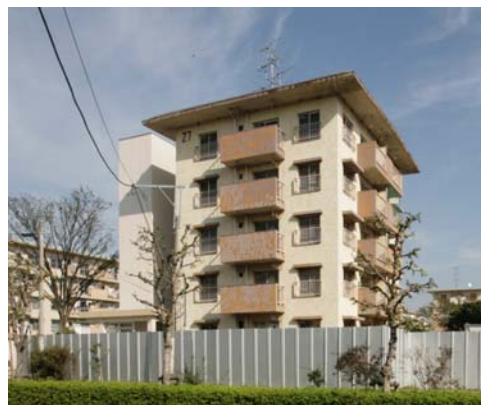
花畑団地27号棟(対象住棟)
