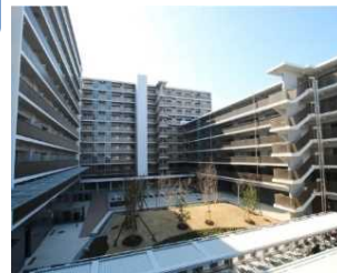
建替え住宅（アーバンラフレ庄内通）
