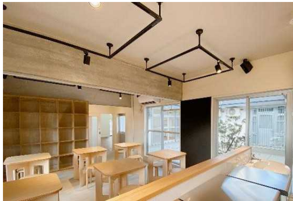
集会所の和室部分を改修
