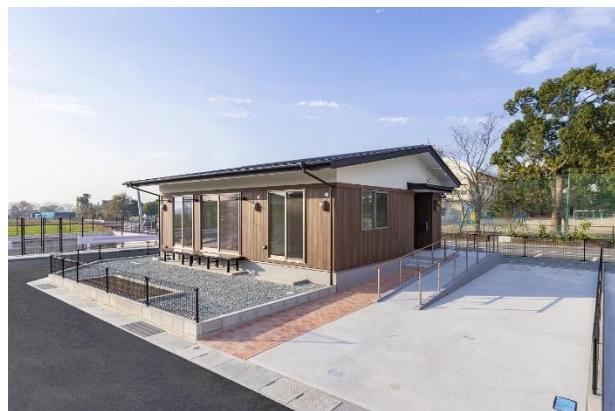
R元.12月竣工 嘉島町荒尾地区
