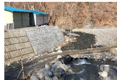
平成28年台風10号 （岩手県岩泉町）
