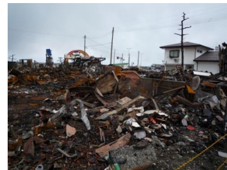
火災による被害状況
