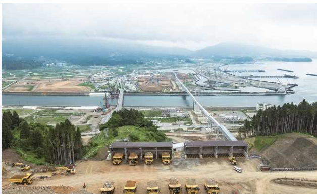
▲ベルトコンベヤを活用し工期を大幅に短縮 一日も早い復興支援に貢献（陸前高田市）
