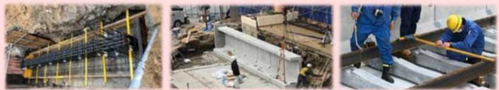
赤胴車設置前の基礎工事、プラットフォーム、線路等の施工
