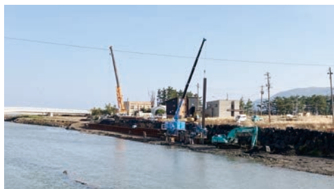
輪島市河原田川復旧工事
