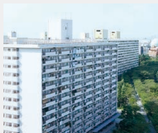
マンモス団地の建設 (高島平団地)
