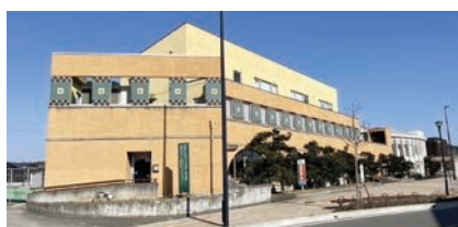
双葉町は、宿泊施設や観光案内機能等の複合施設として、双葉町コミュニティセンターを改修予定、令和9年度の開業を目指し支援を継続中(福島県双葉町)
