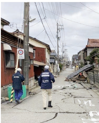
輪島市被災現場確認
