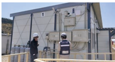
応急仮設住宅の建設支援(石川県穴水町)
