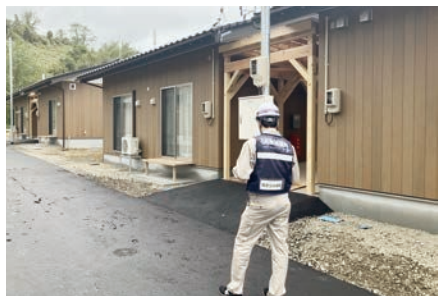
応急仮設住宅完成検査
