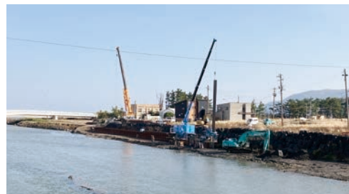
輪島市河原田川復旧工事
