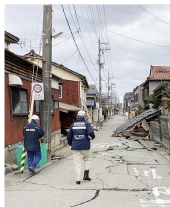
輪島市被災現場確認
