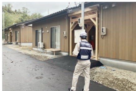
応急仮設住宅完成検査
