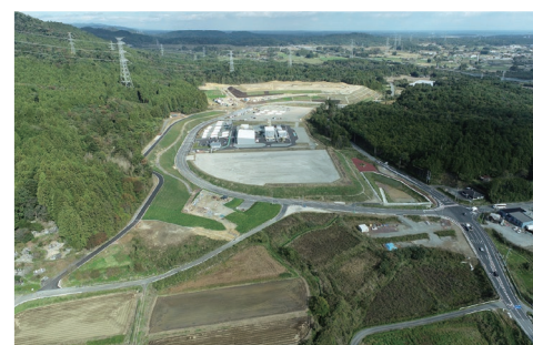
令和7年3月に受託事業が完了した大熊西工業団地 令和6年11月には車用バイオ燃料の生産研究事業所が完成(福島県大熊町)
