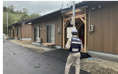
応急仮設住宅完成検査の様子
