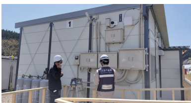
発災後の居住の確保に向けた支援(石川県穴水町)
