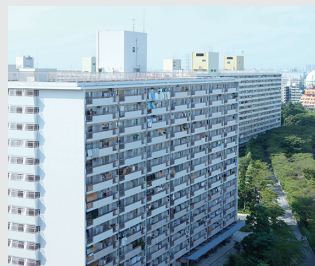
マンモス団地の建設 (高島平団地)
