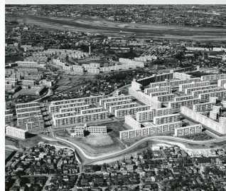
大規模団地の建設 (赤羽台団地)
