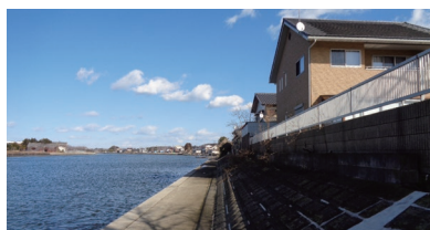
防災集団移転促進事業の推進を通じた流域治水支援(茨城県大洗町)
