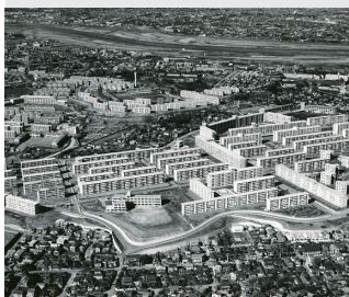
大規模団地の建設 (赤羽台団地)
