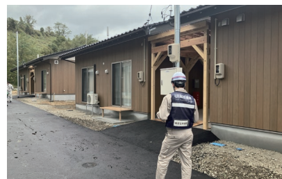
応急仮設住宅完成検査の様子
