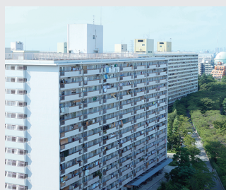
マンモス団地の建設 (高島平団地)
