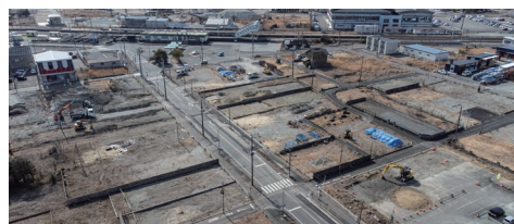
浪江駅周辺地区では、令和6年10月に基盤整備工事に着手(福島県浪江町)
