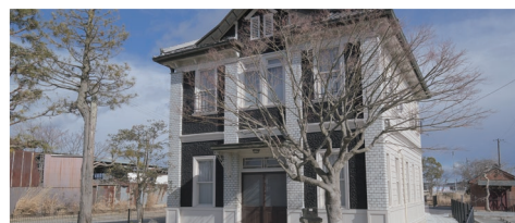
令和6年11月に移住定住相談センターとして開所した旧三宮堂田中医院診療所。URは改修に係る支援を実施(福島県双葉町)
