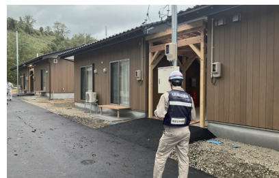
応急仮設住宅完成検査の様子
