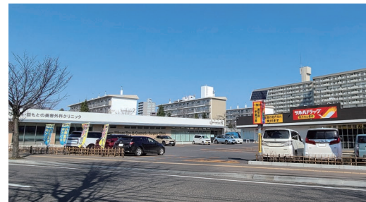
開業したドラッグストア（右）と2軒のクリニック（左）
