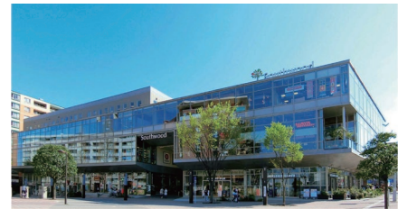
横浜都市みらい サウスウッド (神奈川県横浜市)
