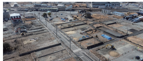
浪江町周辺地区では、令和6年10月に基盤整備工事に着手(福島県浪江町)
