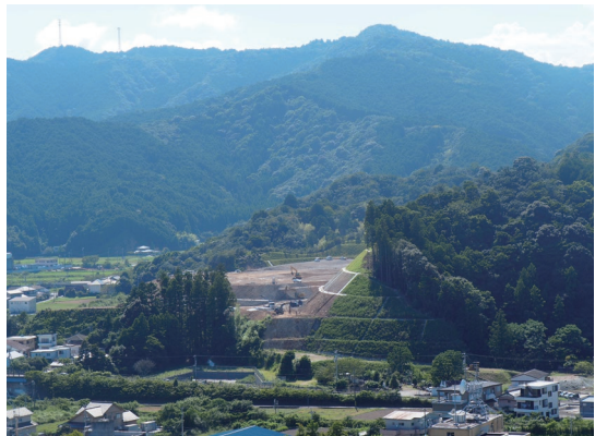
高台造成地（造成中、令和8年度完成予定）
