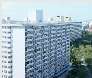
マンモス団地の建設 (高島平団地)
