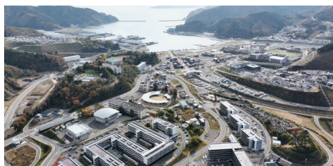
復興市街地の整備を完了した女川町中心部(宮城県女川町)
