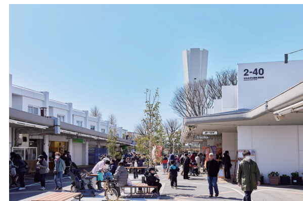
完成した商店街区リノベーション（花見川団地（千葉県千葉市））
