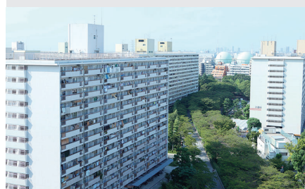
マンモス団地の建設 (高島平団地)
