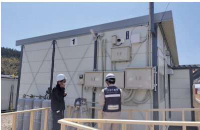
応急仮設住宅完成検査の様子
