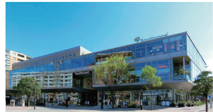
横浜都市みらい サウスウッド (神奈川県横浜市の外観写真。"/>
