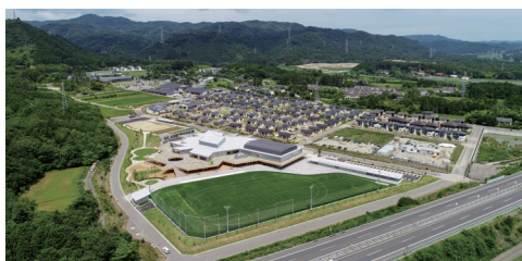
復興拠点の整備を行った大川原地区では、教育施設[大熊町立 学び舎ゆめの森]が完成(福島県大熊町)
