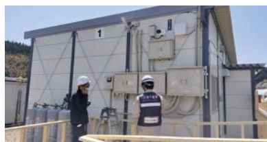
応急仮設住宅の建設支援(石川県穴水町)
