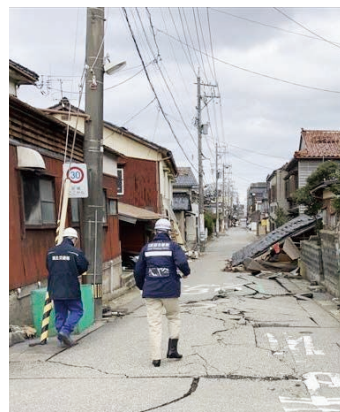
輪島市被災現場確認
