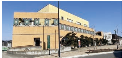
双葉町は、宿泊施設や観光案内機能等の複合施設として、双葉町コミュニティセンターを改修予定、令和9年度の開業を目指し支援を継続中(福島県双葉町)
