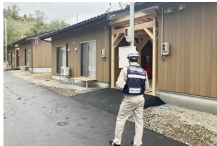
応急仮設住宅完成検査
