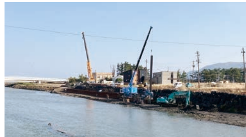
輪島市河原田川復旧工事
