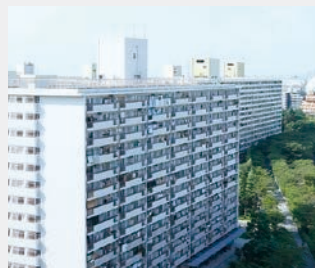
マンモス団地の建設 (高島平団地)
