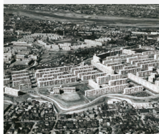
大規模団地の建設 (赤羽台団地)
