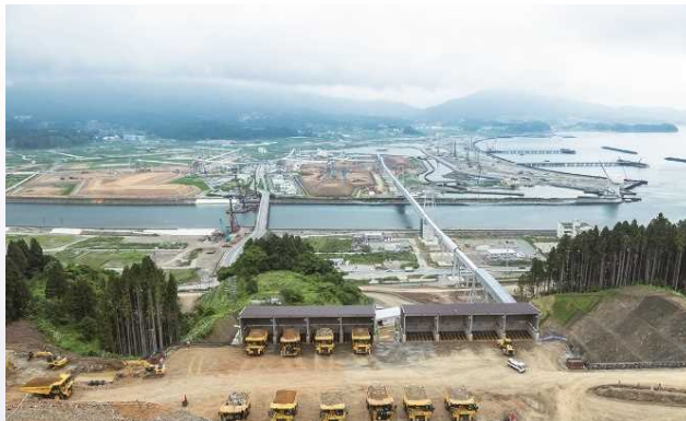
▲ベルトコンベアを活用し工期を大幅に短縮 一日も早い復興支援に貢献（岩手県陸前高田市）
