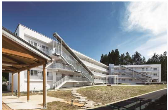
▲町営入谷復興住宅（宮城県南三陸町）
