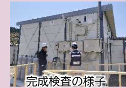
完成検査の様子
