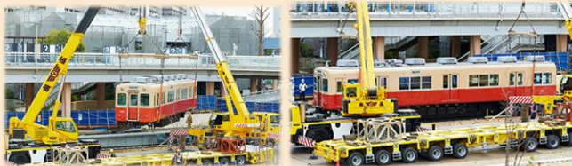
団地内を台車で移動後、クレーンで吊り上げ、広場の線路に設置
