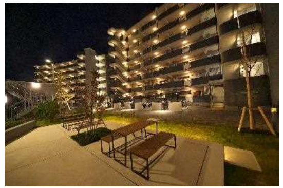
UR賃貸住宅共用部へのLED照明の採用で消費電力の低減を図り、発電に伴うCO 2 発生量削減に寄与
