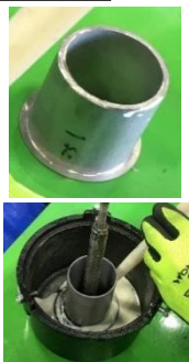
パイプ挿入による接続部の保護
