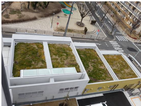
集会所の屋上緑化 アーバンラフレ鳴子 (愛知県名古屋市)
