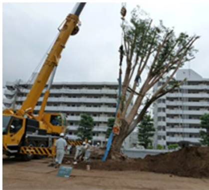
団地の建替事業において、大径木の樺の移植を行った。豊四季台団地(千葉県柏市)
