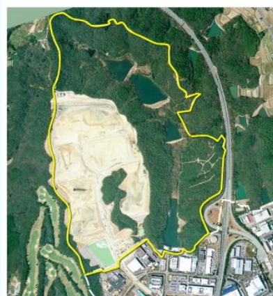
工事中の北摂三田第二テクノパーク (平成 24 年 4 月)
