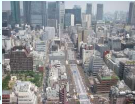
開通後の環状2号線（虎ノ門ヒルズより新橋方面を撮影 H26.6）
