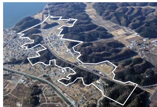
・東松島市 野蒜地区工事完了(H29.3)
