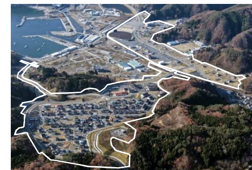
・宮古市 田老地区工事完了(H29.2)
