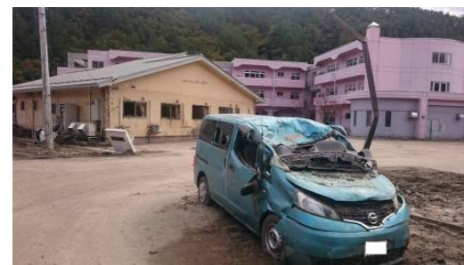
台風による被害状況
