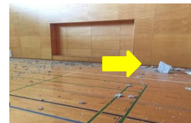
被災後の大津町運動公園 体育館アリーナ内の様子
