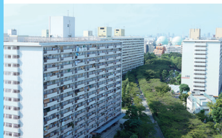
マンモス団地の建設 (高島平団地)
