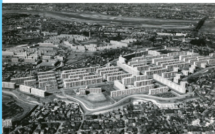
大規模団地の建設 (赤羽台団地)
