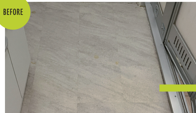
▲従前のビニル床シート
