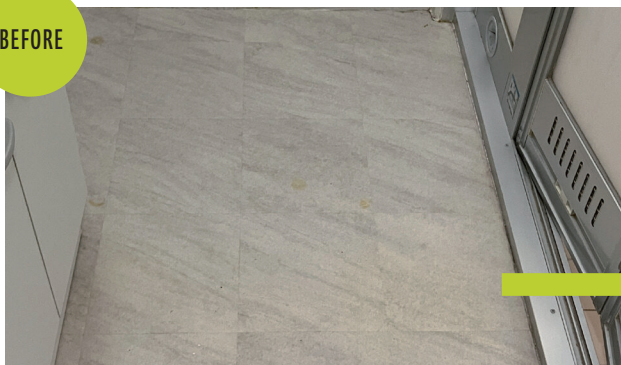
▲従前のビニル床シート
