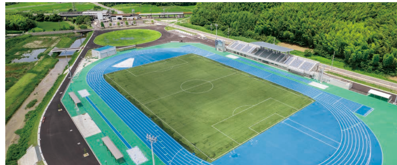
▲美浜町運動公園陸上競技場
