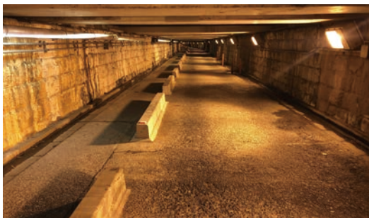
▲お化けトンネル（整備前）
