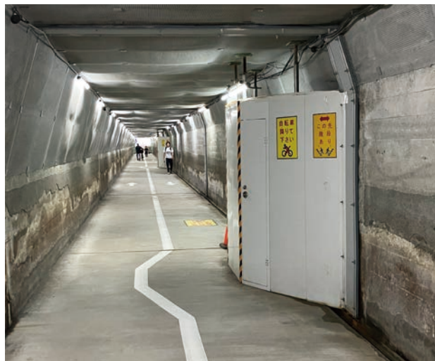
▲活用された暫定の歩行者通路の様子（切替後）
