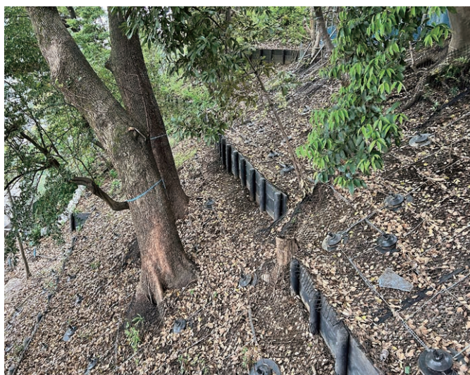
【取組②】斜面対策工事写真
