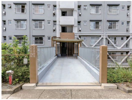
修繕したエントランスとブリッジ
