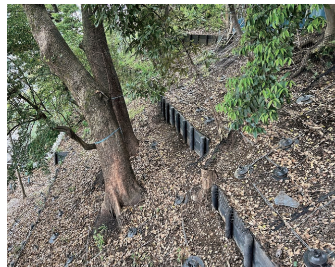
【取組②】斜面对策工事写真
