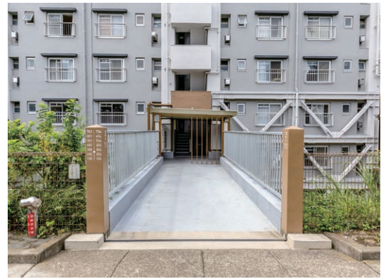
修繕したエントランスとブリッジ
