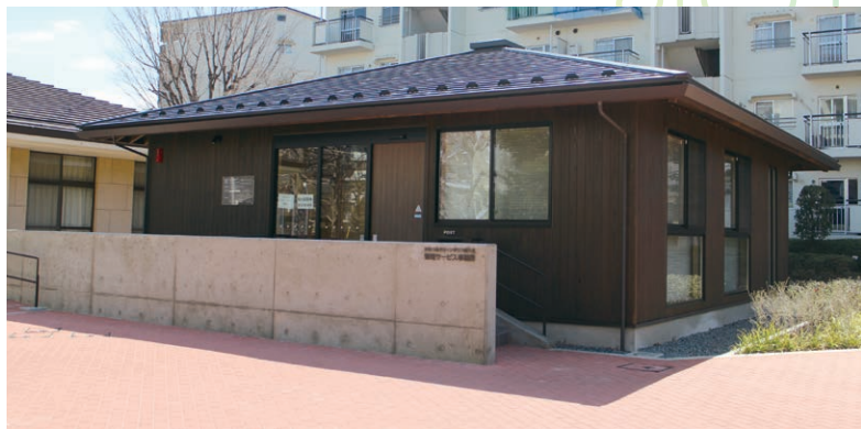
かわつるグリーントウン松ヶ丘 管理サービス事務所 外観
